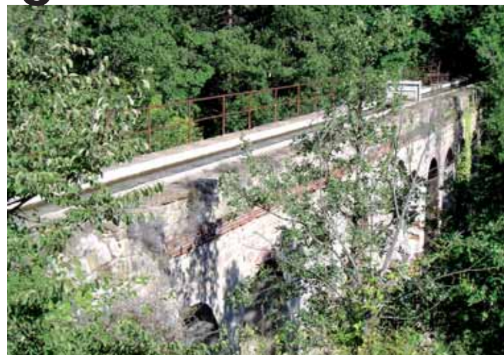
Le canal d'irrigation agricole Bohère, construit au XIX e siècle, est le plus long des Pyrénées-Orientales: 41 km, avec de très nombreux ouvrages (aqueducs, siphons...).
